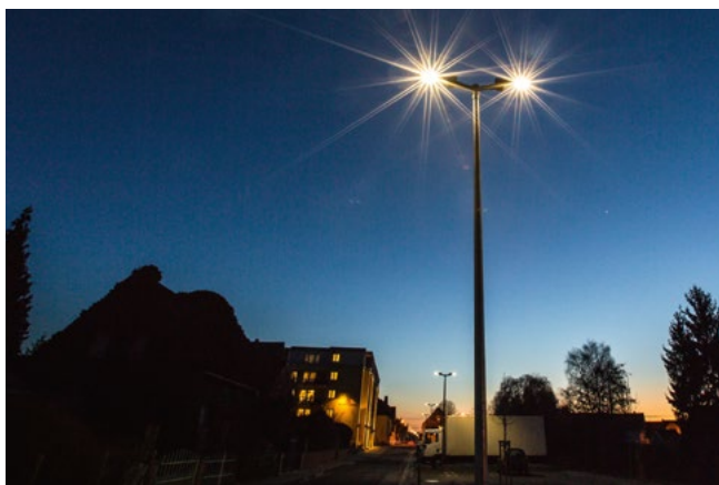
Moderne Straßenbeleuchtung für die Region.
