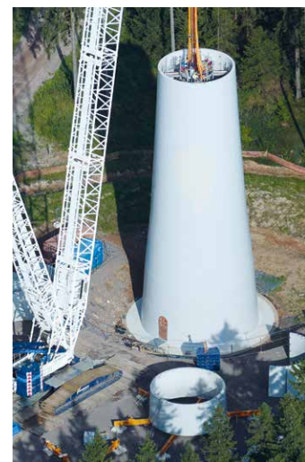
Pro Tag wurden rund 100 Tonnen Stahl verbaut.
